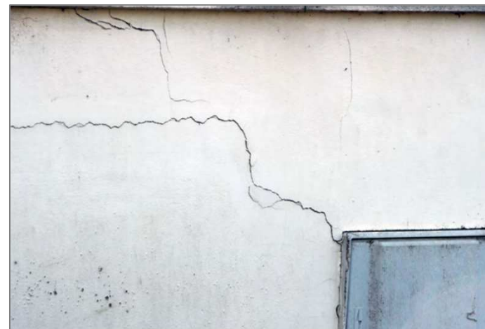
Impact du retrait-gonflement des argiles sur un bâtiment
